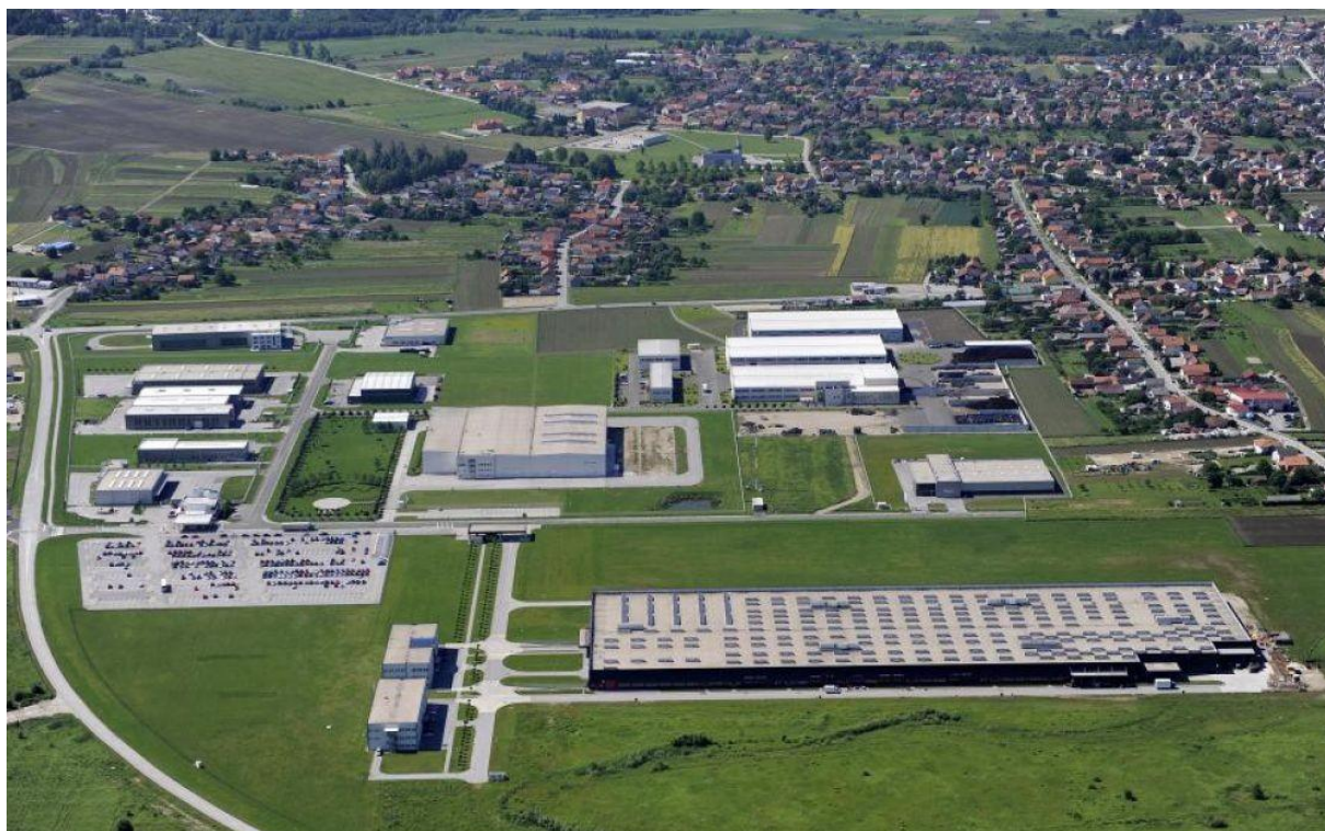
Slika 10. Zona Sjever d.o.o.
